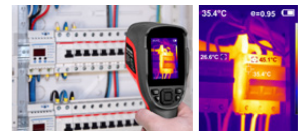
ÜBERPRÜFUNG DER ELEKTROANLAGEN
